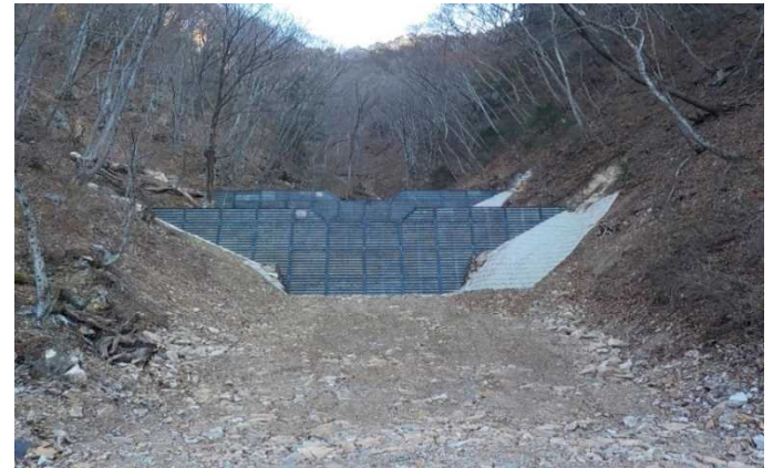
工事完了(H29.12)
