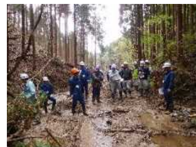
列状間伐・森林作業道に係る現地検討会
