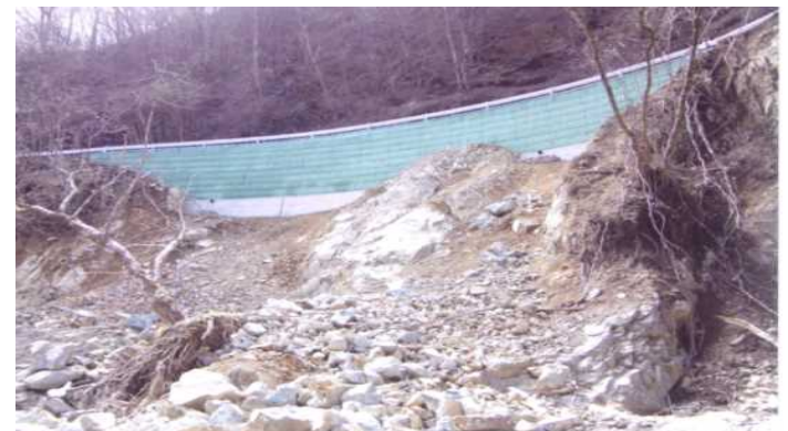
工事完了(平成29年3月)
