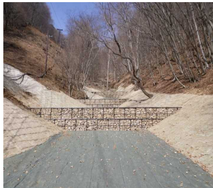
工事完了（平成28年3月）
