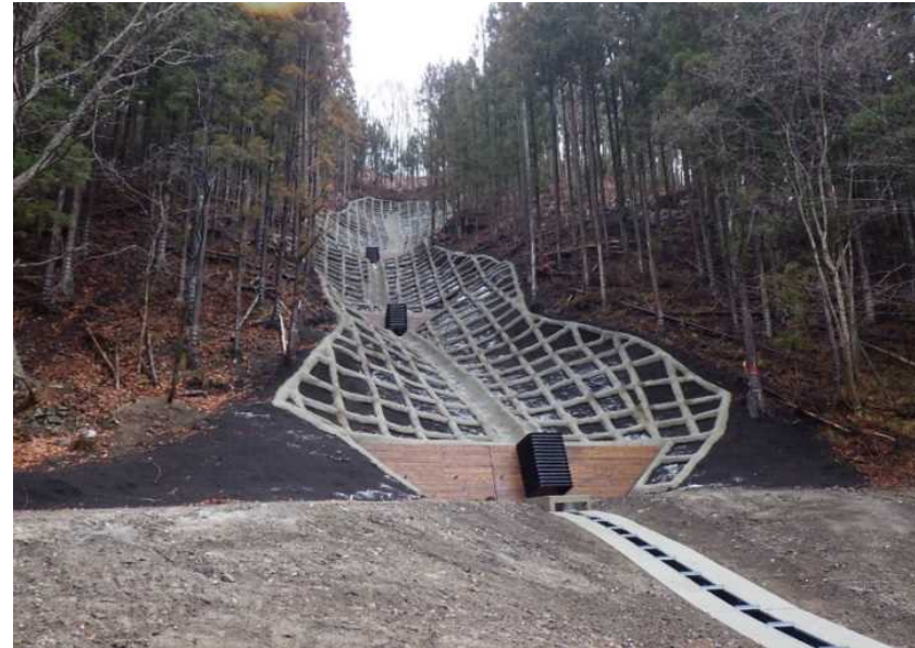
工事完了（平成29年1月）
